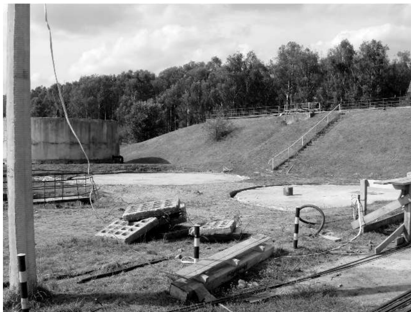
Do niedawna znajdowały się tu złoża biologiczne. Wkrótce powstanie w tym miejscu zbiornik gazu i odsiarczalnia
