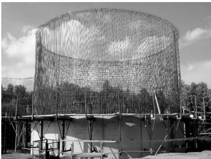
Jedna z dwóch powstających komór fermentacyjnych
