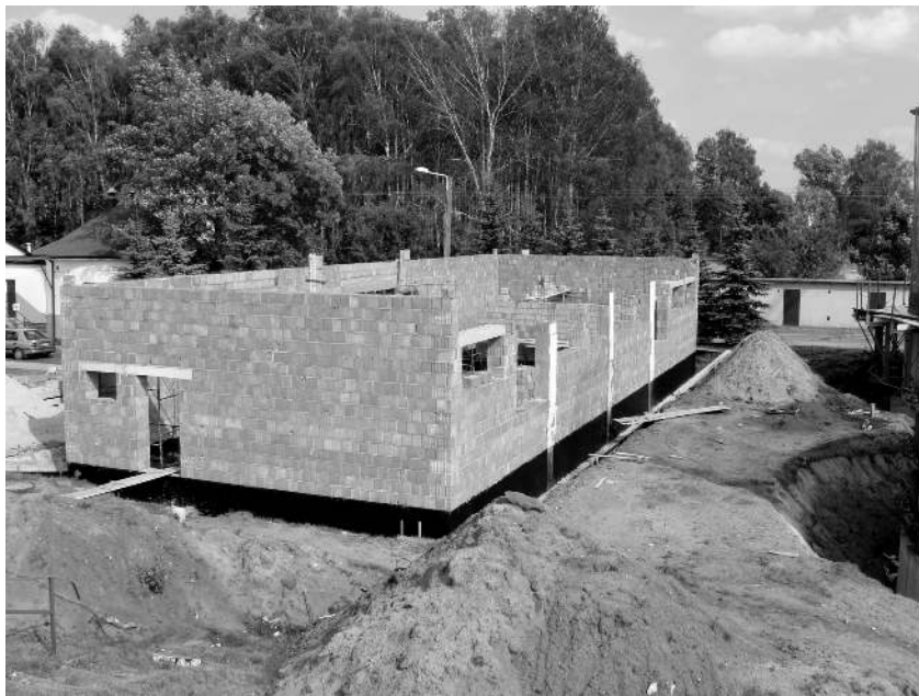
Budynek przyszłej maszynowni
