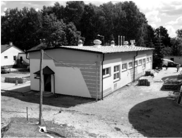
Budynek maszynowni na terenie oczyszczalni.
