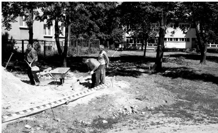
Prace budowlane przy Szkole Podstawowej Nr 1
