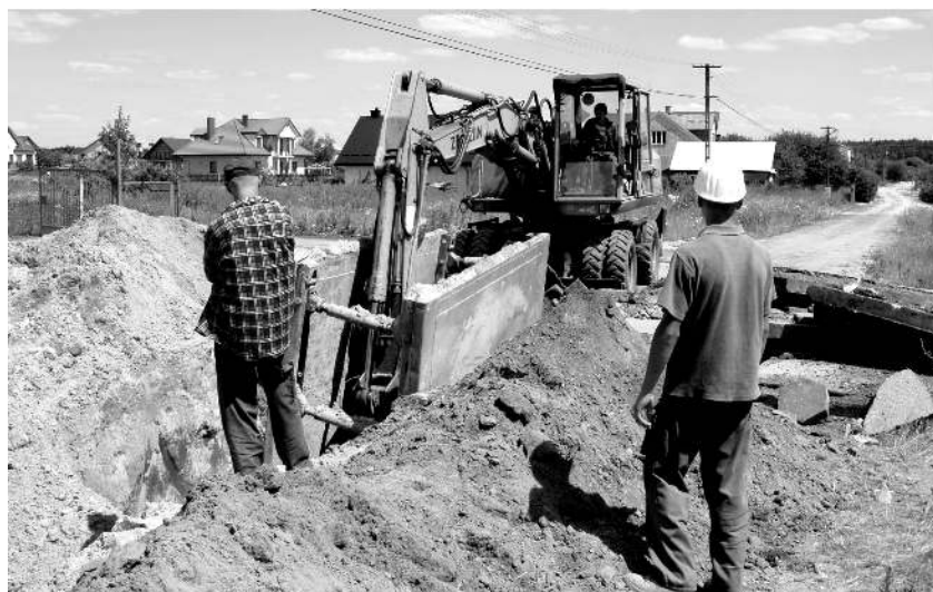
Prace nad budową kanalizacji w osiedlu Piaski potrzebują jeszcze rok.
