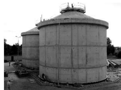
Komory fermentacyjne w oczyszczalni ścieków.
