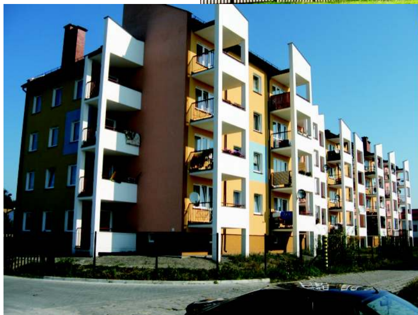
ul. Zamojska 84a. Widok od strony podwórka.
