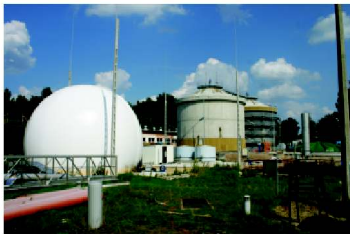
Obiekty gospodarki osadowo - gazowej w Miejskiej Oczyszczalni Ścieków.
