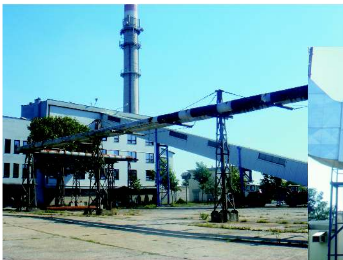
Ciepłownia centralna przy ul. Krzeszowskiej.
