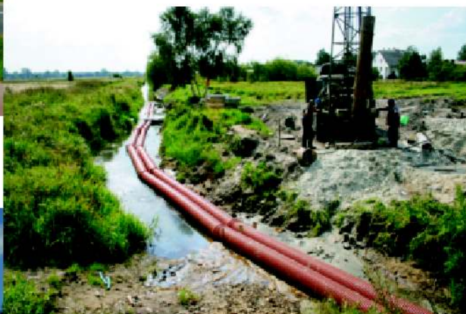
Kanalizacja w osiedlu Piaski.
