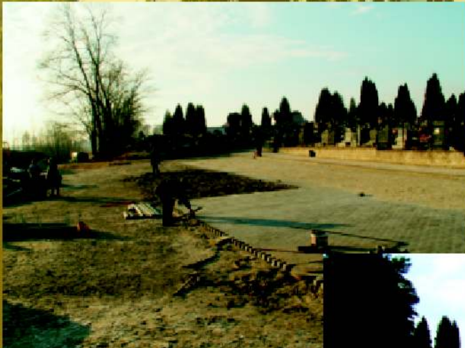
Niezagospodarowany plac obok cmentarza przy ul. Lubelskiej.
