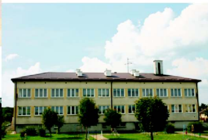
Nowa więźba dachowa w Przedszkolu Samorządowym nr 2.
