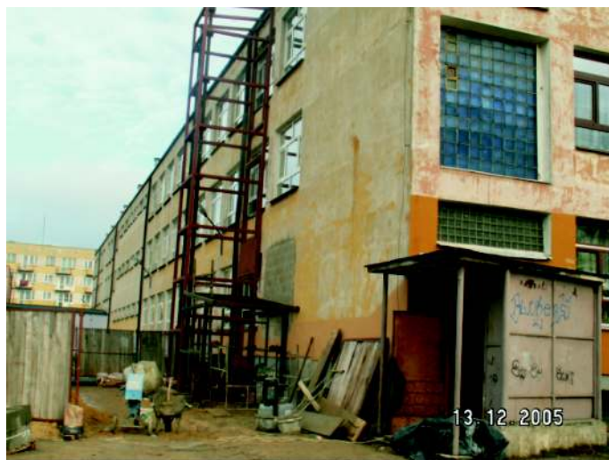
Prace przy montażu windy dla niepełno- sprawnych w MZS
