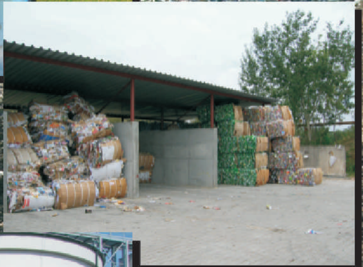
Magazyn zebranych selektywnie odpadów
