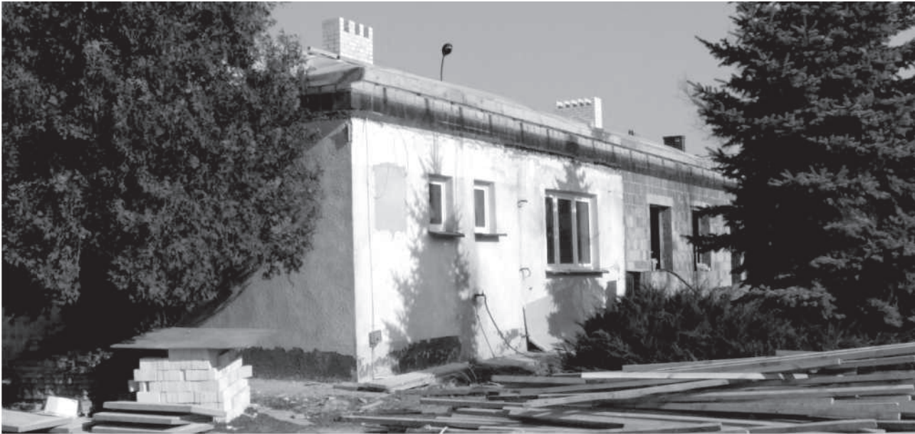
Trwa remont budynku dla pomieszczeń społecznych BPS Sp. z o. o.
