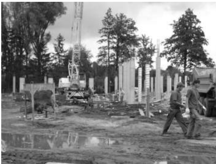
Plac budowy hali sportowej, sierpień 2008
