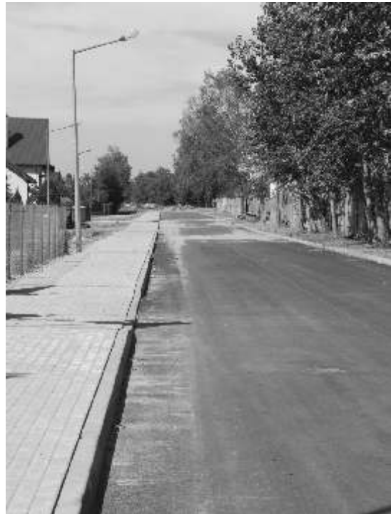
Nowy chodnik i nawierzchnia na ulicy Armii Krajowej
