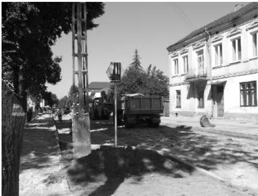
Trwa budowa nawierzchni ulicy Wacek Wasilewskiej
