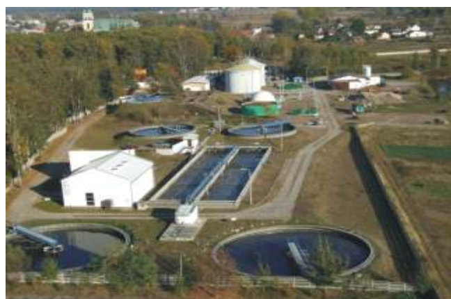
Miejska Oczyszczalnia Ścieków. Fot. A. Dechnik
