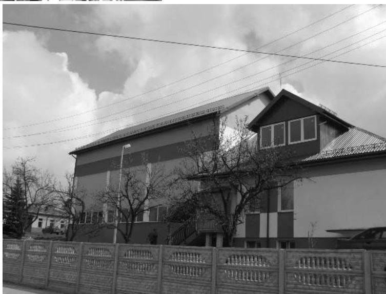
Stacja uzdatniania wody i pompownia są przebudowywaną i unowocześniane
