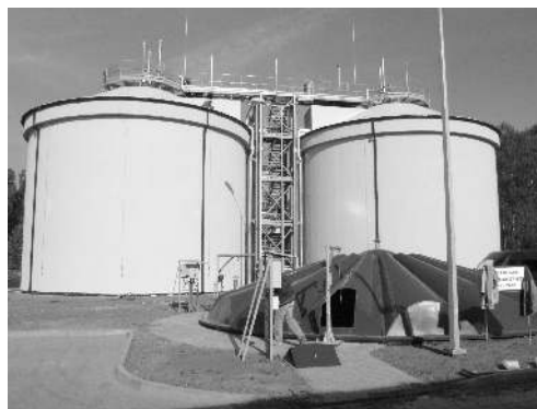
Obiekty w naszej oczyszczalni powstały wg najnowocześniejszych technologii
