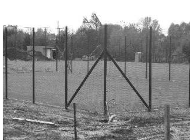
SP nr 5 Orlik 2012 w trakcie realizacji.
