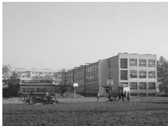
Budowa nowego boiska przy MZS
