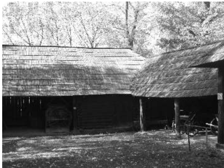
Budynki gospodarcze zagrody, w których pierwotnie przechowywano wozy i żywy inwentarz. Obecnie jest w nich ekspozycja rzemiosł związanych z obróbką drewna
