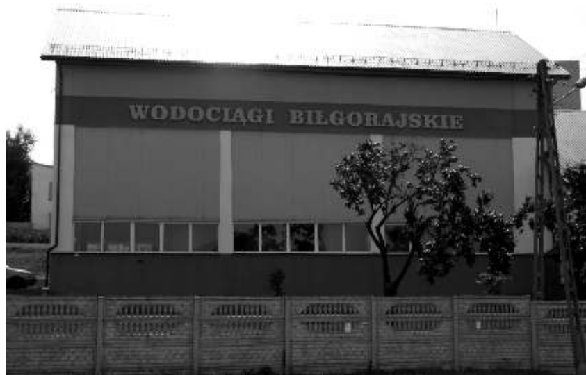
Nowoczesna Stacja Uzdatniania Wody
