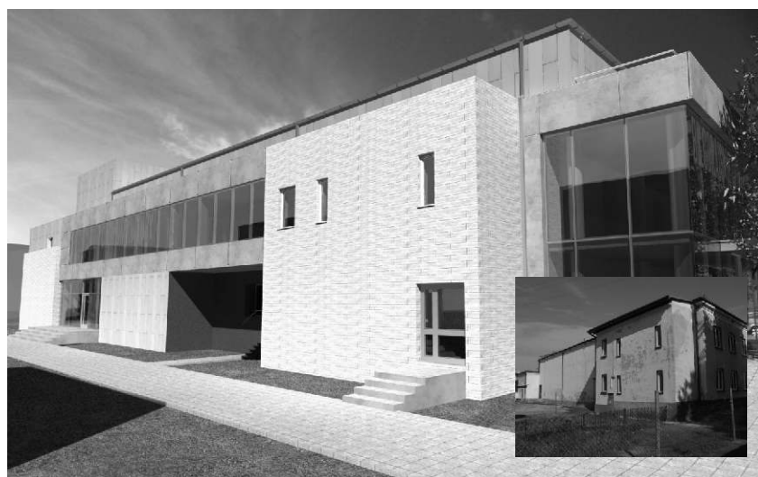
Widok od strony południowej
