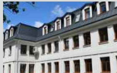
Budynek Dziennego Domu Pomocy dla seniorów
